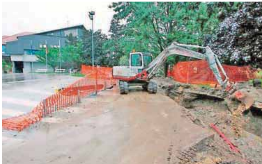
Pri stavbi gledališča menjajo predimenzionirane nadzemne cevi vročevoda, nove bodo vgradili pod zemljo. / FOTO: GORAZD KAVČIČ
